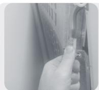
Encaixe a mangueira na conexão de gás
