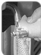
5. Após a instalação, verifique se há vazamento de gás, abrindo o regulador de pressão e colocando um pouco de espuma de sabão em todas as conexões que foram manuseadas. Se houver formação de bolhas, feche o registro do regulador e refaça a operação ou consulte a **Rede de Serviços Brastemp**.
